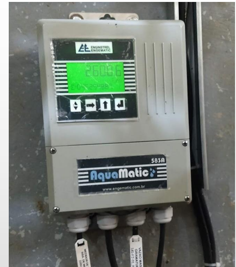
583A: Instalação Remoto
